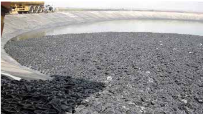
Hexa-Cover® : BULK - levering og installation
