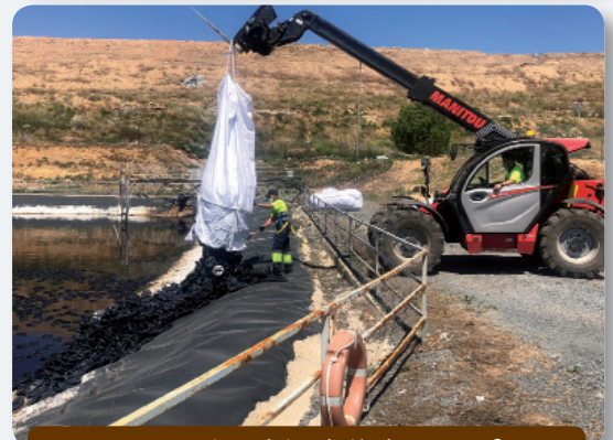
Imagen 4 y 5. Operaciones de instalación de HexaCover® Image 4 & 5. HexaCover® installation operations
