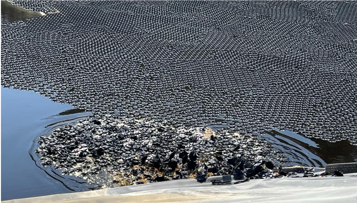
Foto 6: Distribución automática durante la instalación de Hexacover®
