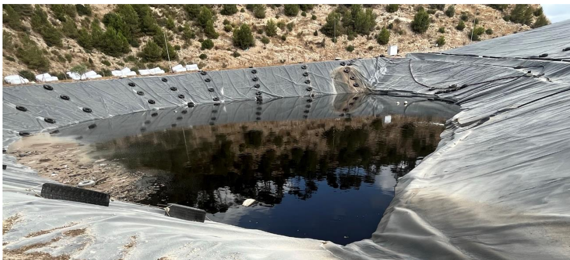
Foto 2: Balsa de lixiviados
