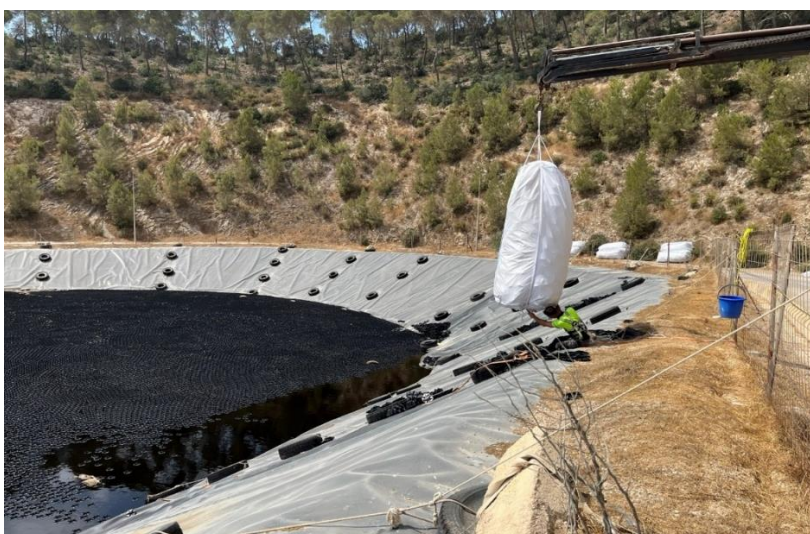
Fotos 4 y 5: Operaciones de instalación de Hexacover®
