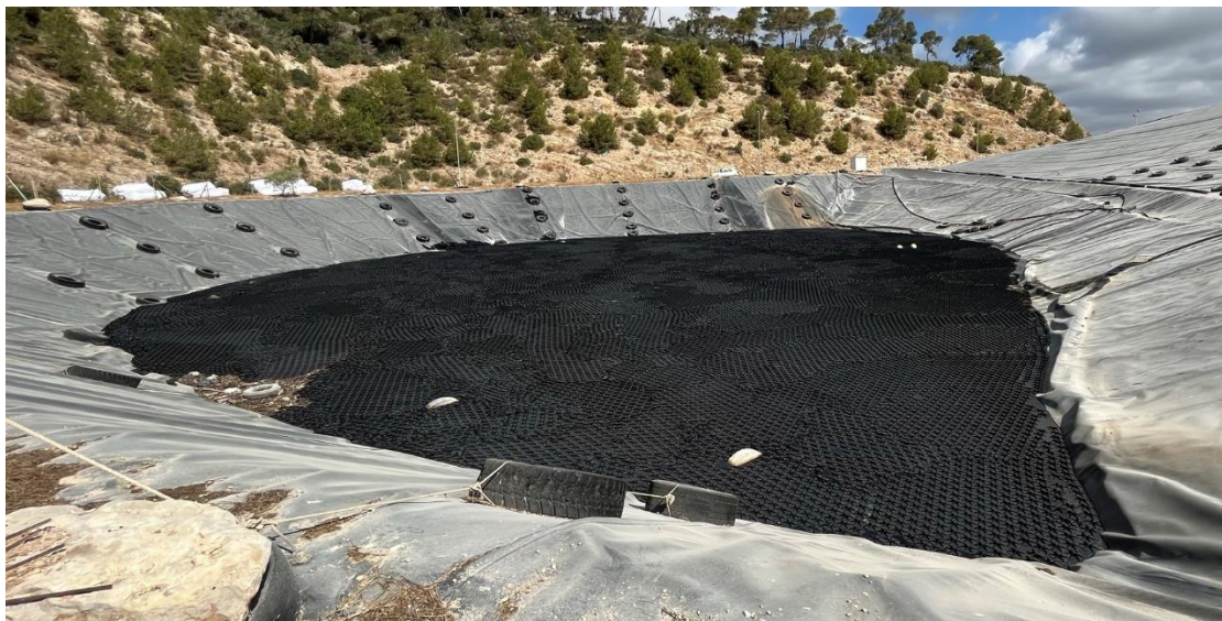
Foto 7: Cubierta flotante Hexacover® instalada
